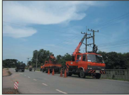
รูปที่ 2 - 2 การดำเนินการย้ายเสาโทรคมนาคมออกจากเขตก่อสร้าง
