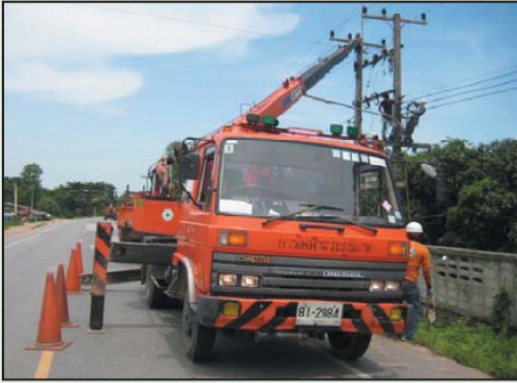
รูปที่ 2 - 2 การดำเนินการย้ายเสาโทรคมนาคมออกจากเขตก่อสร้าง
